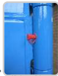
Alle beweglichen Teile sind mit Schmiemippen versehen
