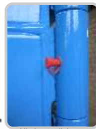
Alle beweglichen Teile sind mit Schmiemippen versehen
